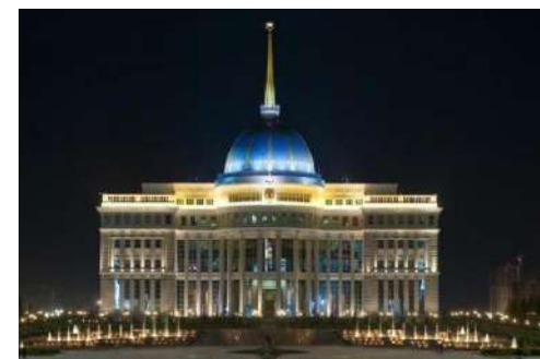
Архитектурное освещение зданий
